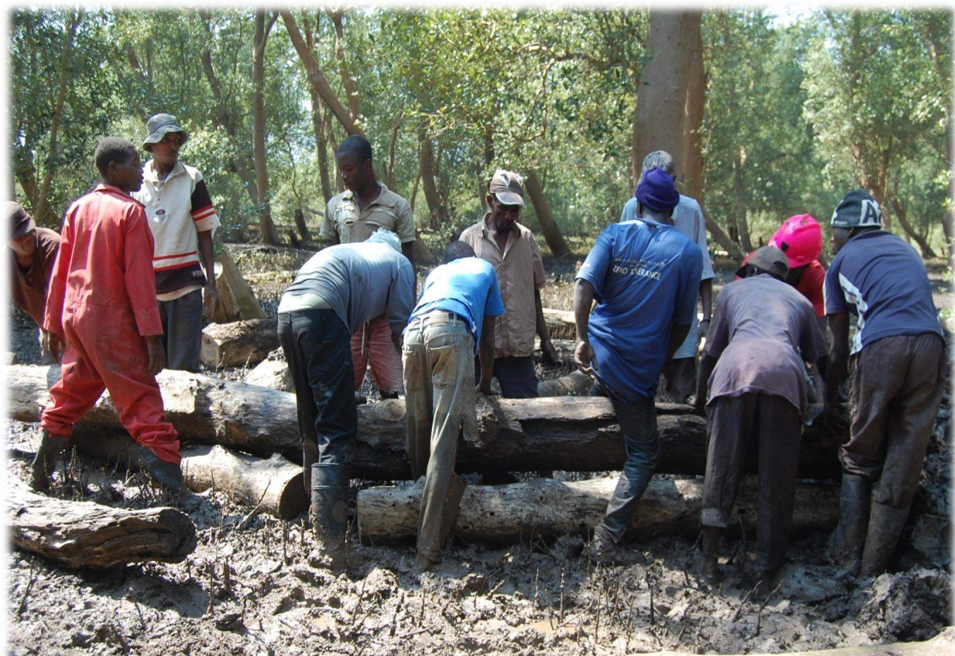
Carregamento de troncos para construção da barragem
